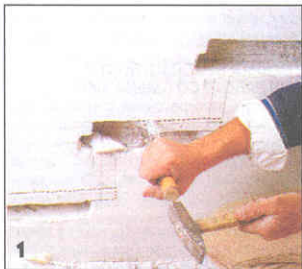
По размеченному положению ступеней в стене зубилом выдалбливают пазы, предварительно просверлив в пределах обозначенных контуров несколько отверстий.
