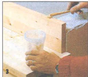
Проступи с подступенками склеивают. Предварительно на опоры, чтобы выставить ступени горизонтально по уровню, наносят слой раствора необходимой толщины.
