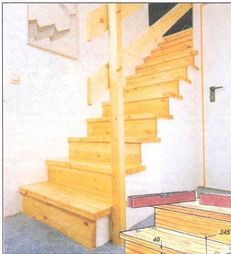
Детали этой подвальной лестницы сделаны из соснового стоелярного щита, отшлифованы и в три слоя покрыты паркетным лаком.
